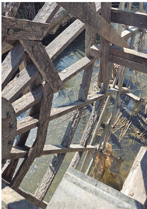
Acumulación de residuos en el encuentro entre las paletas y el canal; requiere limpieza e inspección periódicas.
