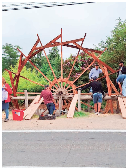
Instalación completa de rayos y trabas. Archivo fotográfico de María Célis.
