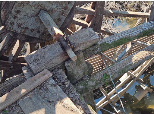
Anclaje a viga con piola metálica para tiro con tecle.
