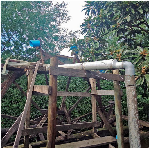
Referente de tubería en rueda de agua de Arturo Lucero.
