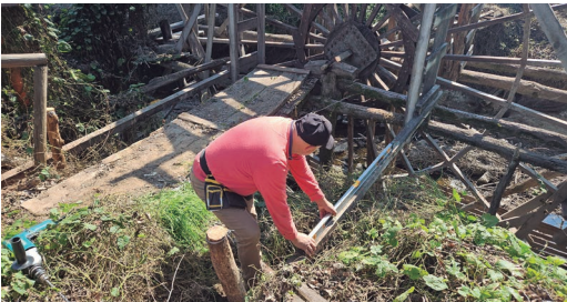
Instalación y nivelación de contrafuerte exterior (tronco de Acacio) para asegurar posición de estructura base con estaca a tierra.
