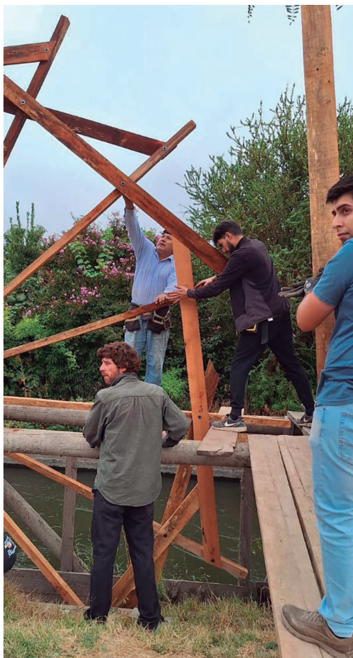
Instalación de trabas a medida que se avanza con la instalación de rayos. Archivo fotográfico de María Célis.
