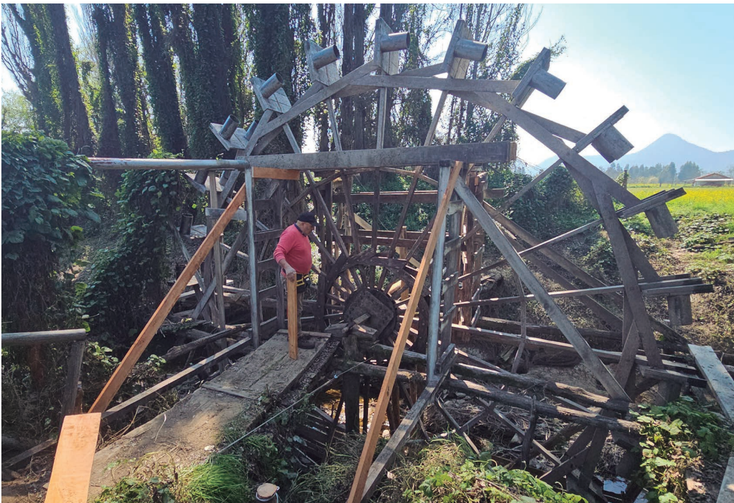
Vista de diagonales para arriostramiento de porta canoa.
