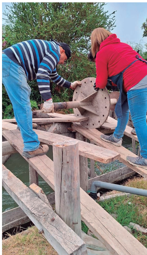
Traslado del eje y masa a su posición en estructura base. Archivo fotográfico de María Célis.
