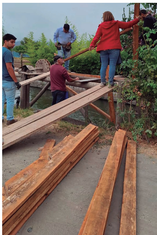
Instalación de primeros rayos en la masa de la rueda. Archivo fotográfico de María Célis.
