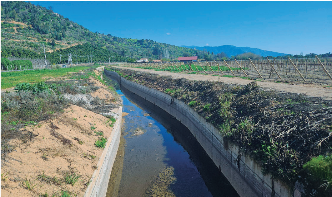
Foto de tramo de canal Almahue con revestimiento de h.a.
