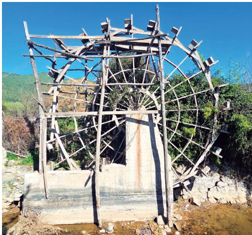
Rueda de Otilia Zamorano Villaseca, de diámetro de 8 m, con 24 rayos, capachos de madera y base de hormigón.
