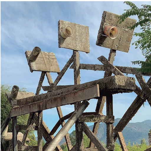
Trabas faltantes y fuera de su posición.
