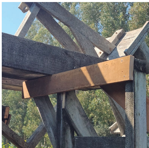
Vista de canoa con piezas nuevas instaladas para refuerzo y arriostramiento de estructura. Rueda Mirador 1.
