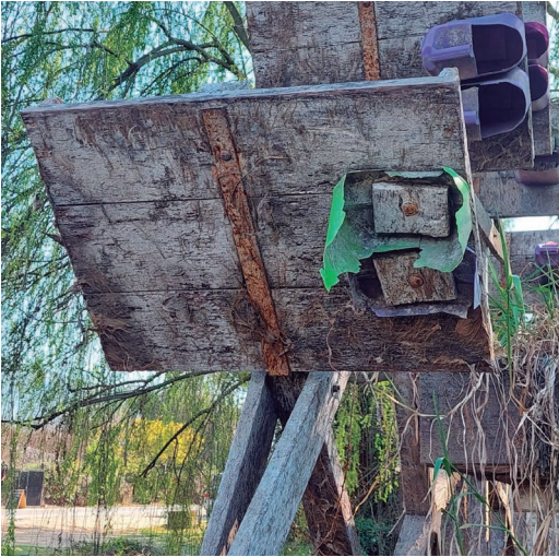
Capachos de envases reciclados con daño mayor (no recomendados).
