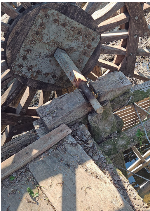
Eje sin protección.
