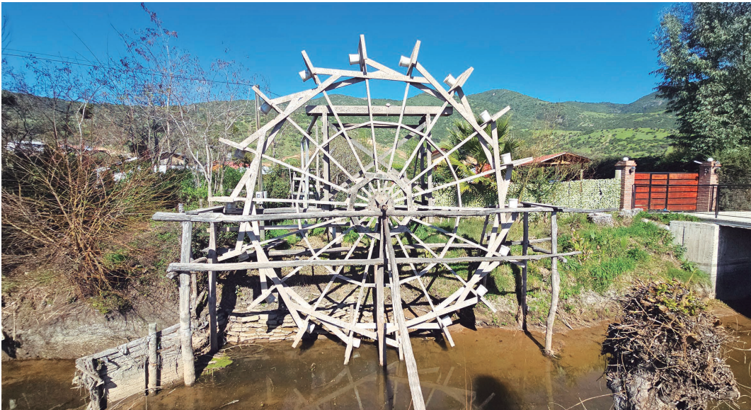
Ejemplo de estructura base tradicional de madera instalada en canal sin revestimiento.
