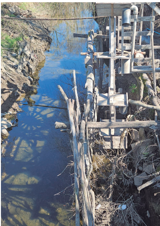
Acumulación de residuos en el encuentro entre las paletas y el canal; requiere limpieza e inspección periódicas.
