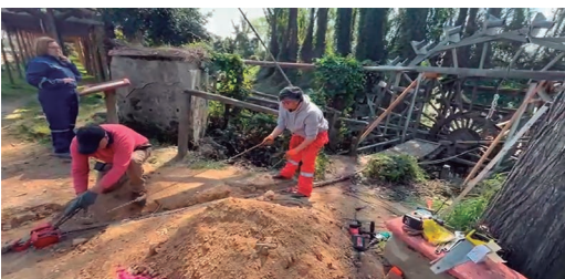
Instalación de tecle para reposicionamiento correcto de estructura base.
